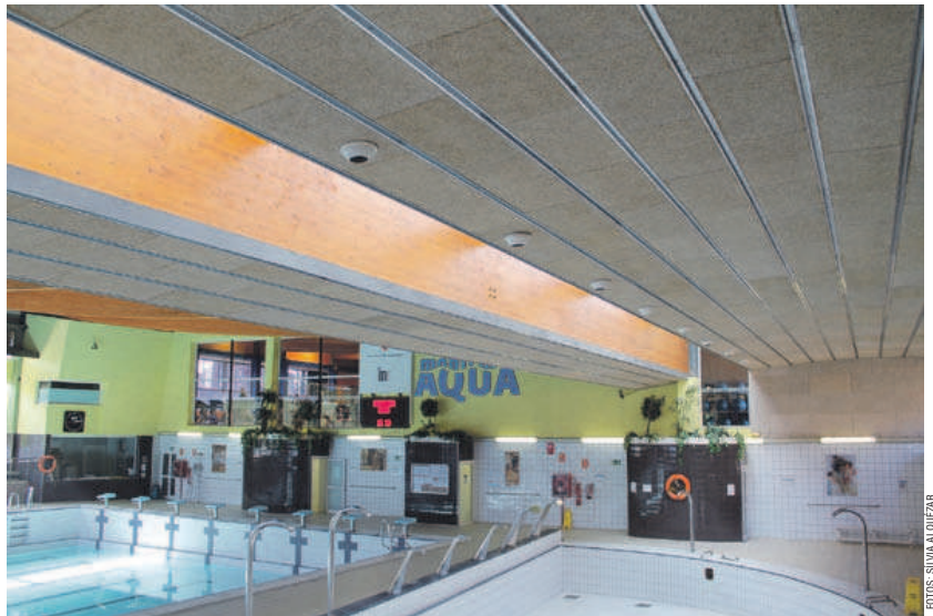
Una de les modificacions que s'han fet ha estat arreglar tot el fals sostre de la instal·lació que havia sofert alguns danys importants
