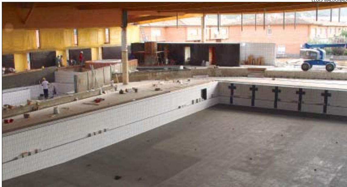
&gt;&gt; Les obres per construir la piscina central, el jacuzzi i la zona termal estan pràcticament enllestides
