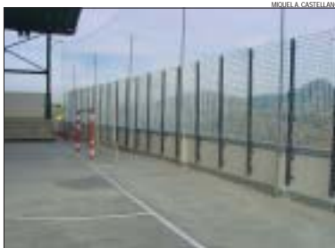
>> A les pistes de Can Cuiàs s'han instal·lat tanques metàl·liques i una xarxa
